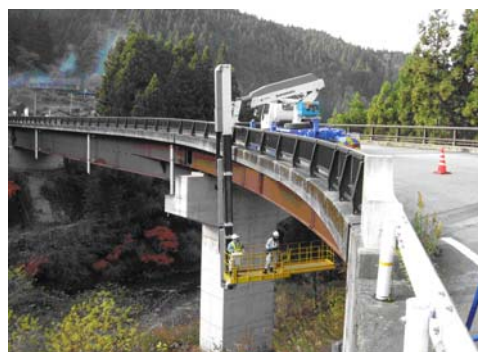
写真-3.2 専門業者による点検状況
