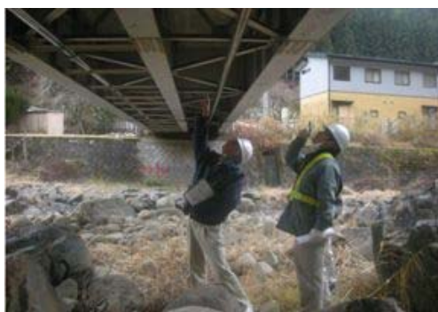
写真-3.1 職員による点検状況
