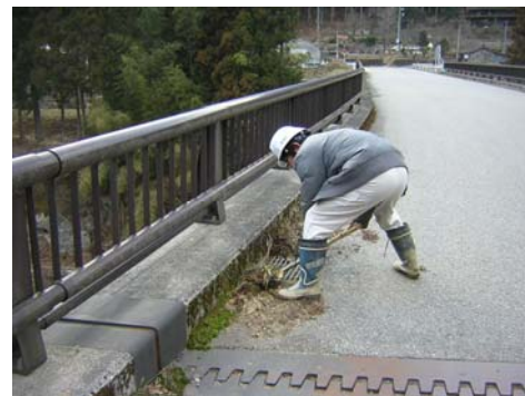
写真-3.4 堆積土砂除去状況
