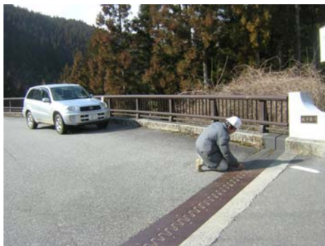
写真-3.3 目視点検状況
