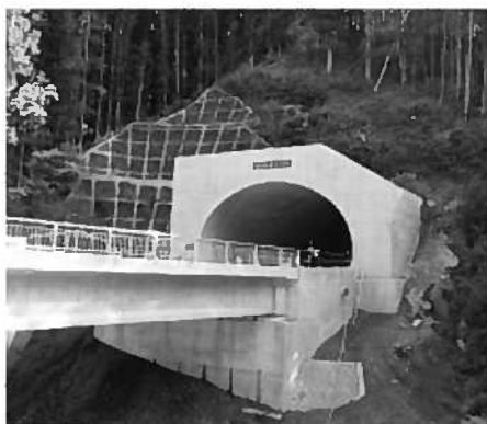
開通を待つ新太和金トンネル
