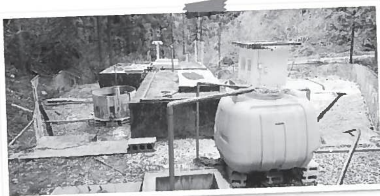
▶旧間当浄水場で養殖場の整備中
