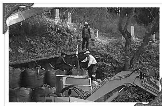
墓地進入路法面補修工事（栗世組）
