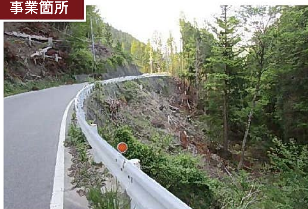
主要地方道阿南東栄線(三沢地内)
