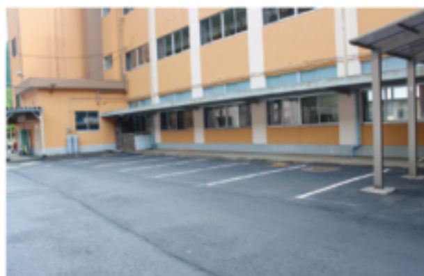
豊根中学校裏駐車場舗装改修工事
