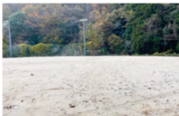
森遊館グランド整備工事
