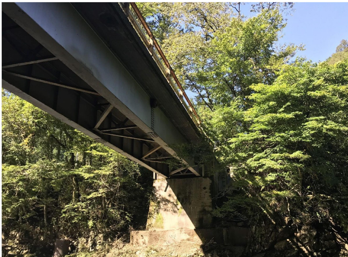
（林道上黒川線 砥久保橋）
