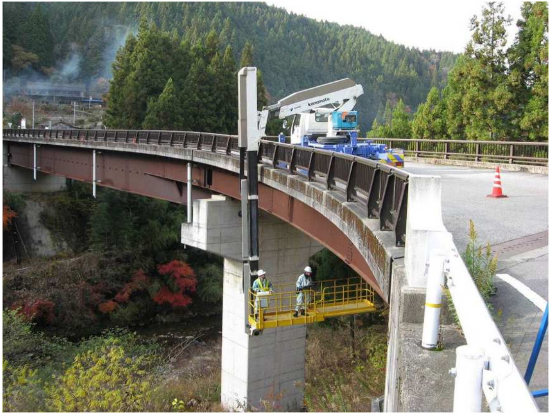
(橋梁点検車による点検・村道黒川坂宇場線 塩瀬橋)
